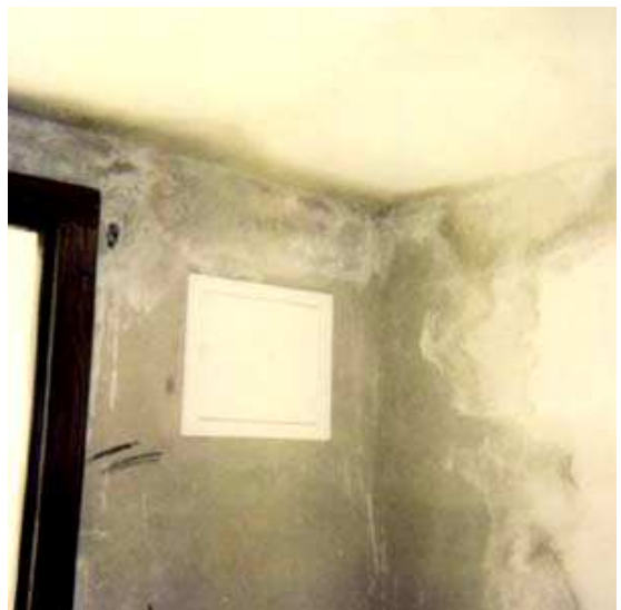
Bild 7.2.1. : Gipskalkputz im Kellerraum eines 1,5 Jahren Einfamilienhauses
