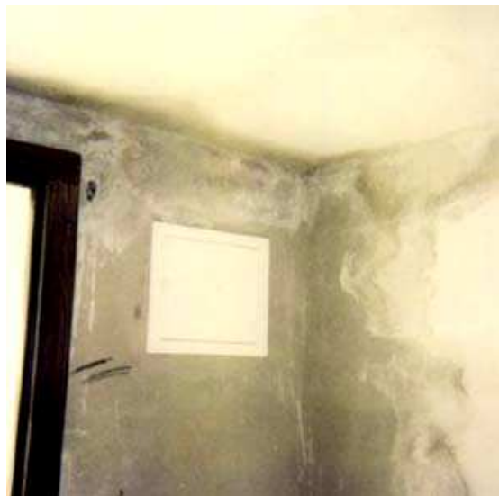
Bild 7.2.1. : Gipskalkputz im Kellerraum eines 1,5 Jahren Einfamilienhauses
